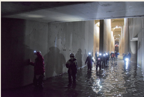
首都圏外郭放水路（埼玉県）
