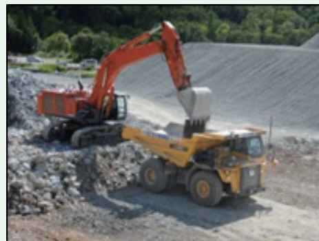
東北地方整備局 成瀬ダム原石山工事（秋田県）
