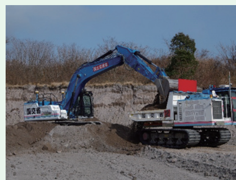
九州地方整備局 令和7年度赤松谷川堰堤群補修その他工事 (長崎県)
