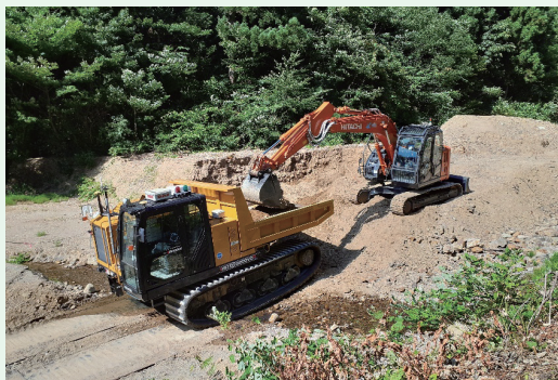
東北地方整備局 立谷沢川上流松沢地区管理用道路整備工事 (山形県)
