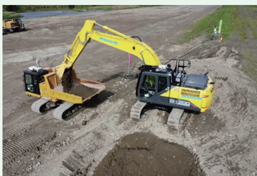
近畿地方整備局 慈尊院地区掘削他工事 (和歌山県)
