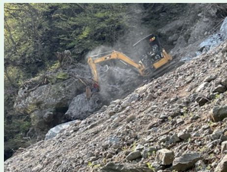
関東地方整備局 R6 馬返崩壊地対策工事 (栃木県)
