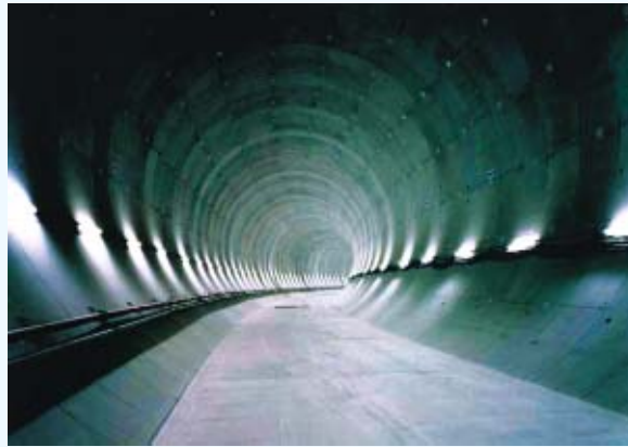
第1工区トンネル
