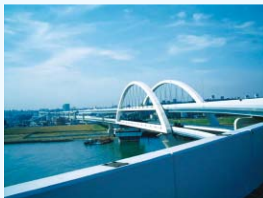
五色桜大橋（荒川付近）
