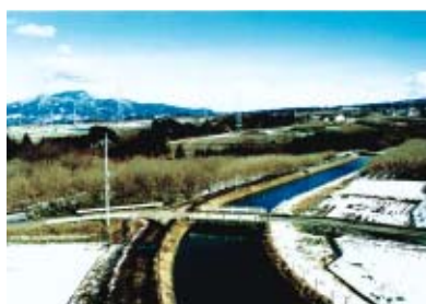
群馬用水の現況及び老朽化による既設管破裂例
