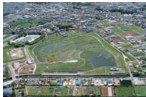
図表 2-4-2 大柏川第一調節池緑地の外観
