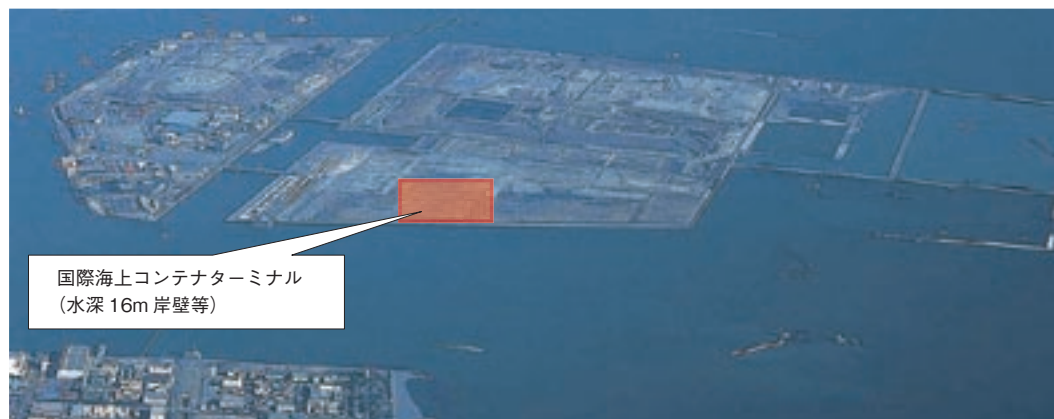
図表 2-6-12 東京港中央防波堤外側地区
