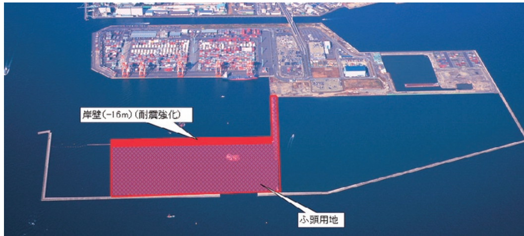
図表 2-6-13 横浜港南本牧ふ頭地区
