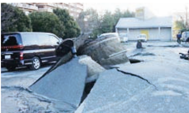
図表1-1-12 液状化によって拔上ったマンホール（浦安市内）
