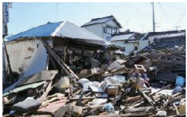
図表1-1-7 津波による倒壊家屋と押し寄せたがれき（旭市飯岡）
