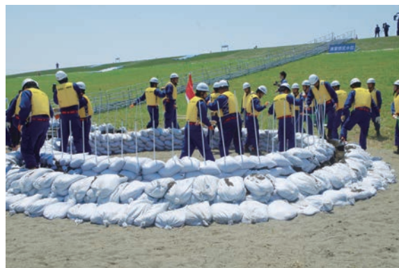
水防団による水防工法（釜段工）
