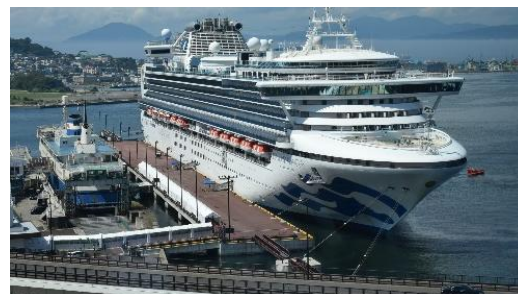
函館港に寄港するクルーズ船 (2023年に供用開始した大型クルーズ船対応岸壁)
