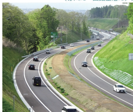
▼ 広域分散型社会を支える交通ネットワークの形成 (函館新外環状道路 空港道路 (赤川IC~函館空港IC))
