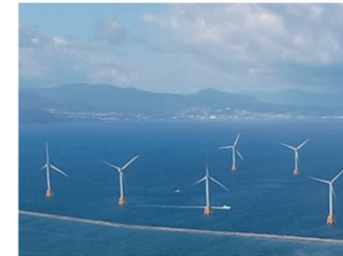
▲ 洋上風力発電の導入促進 (石狩湾新港洋上風力施設)
