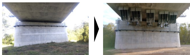
図11 橋梁の耐震対策事例(土狩大橋(芽室町))
