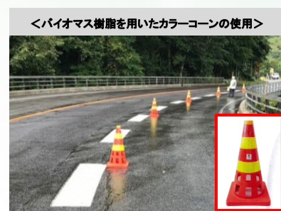
図17 北海道インフラゼロカーボン試行工事の事例
