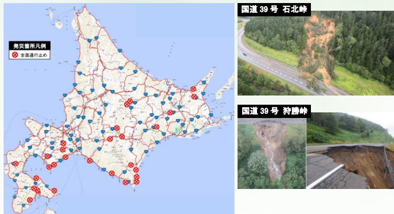
図4 平成 28 年8月北海道豪雨における国道の通行止め状況
