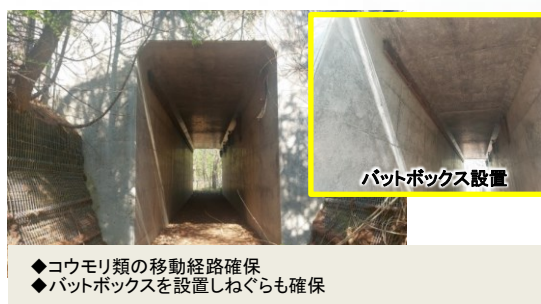
図6 エコロードの設置状況
