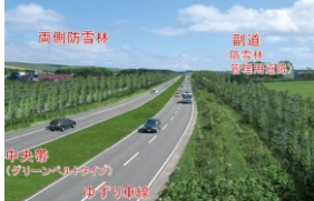
(「北海道スタンダード」を適用した 国道40号更喜内防雪)
