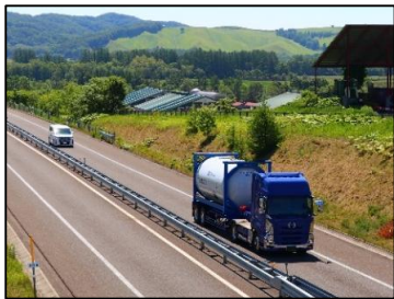
開通済み区間の通行状況
