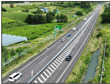
開通済み区間の通行状況
