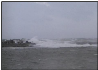
防波堤の越波状況
