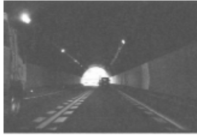
図1 料金所手前の事故現場となったトンネル
