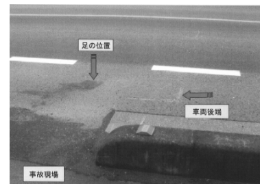
図 2 縁石の設置状況
