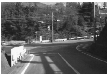
図1 当該事故現場となったT字路
