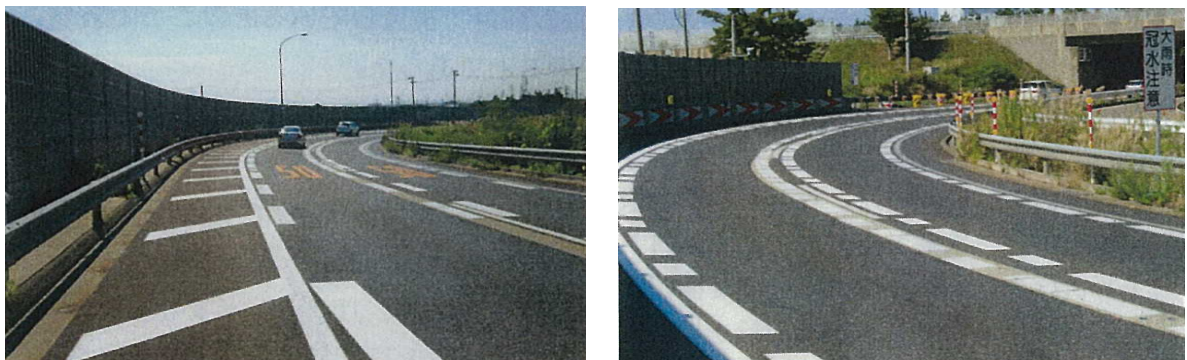
図3 事故後の対策（車線を狭く感じさせ減速を促す道路標示）
