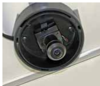
(カバーを外した状態)
