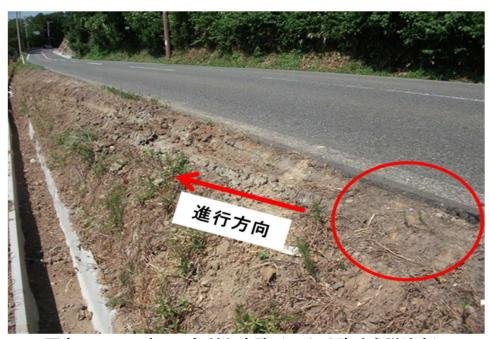
写真2−2 法面のわだち痕跡(○印は路外逸脱地点)
