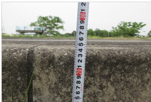
写真5—1 中央分離帯縁石高さ
