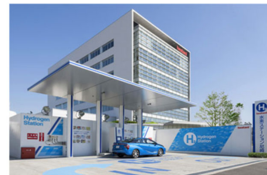
水素ステーション
