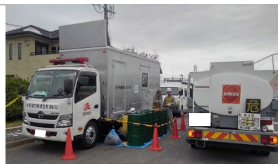
移動電源車に燃料を届けたタンクローリー （千葉県館山市）
