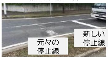
写真2 停止線位置の変更 (福岡県北九州市)
