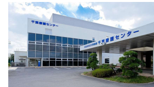
老朽化する千葉療護センター (築38年)のリニューアル
