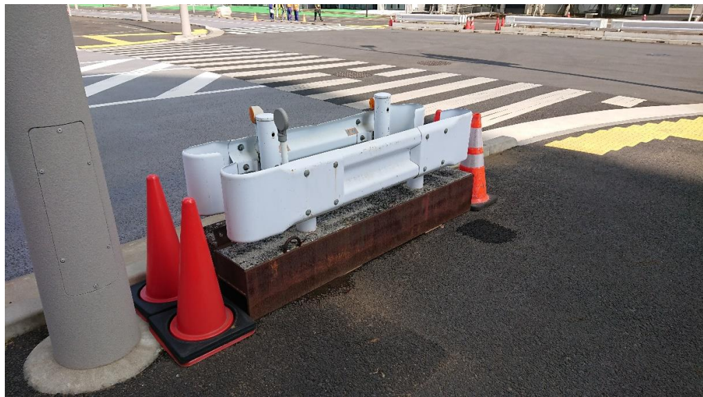
図8 横断防止柵（仮設ガードレール）の設置状況（写真①）
