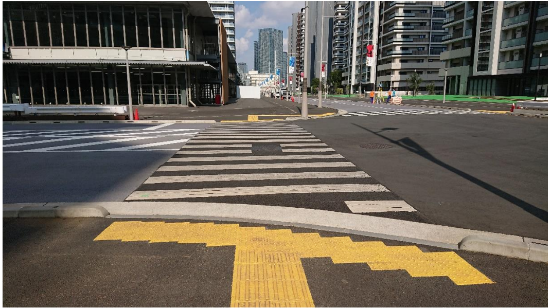
図 10 横断歩道接続部における視覚障がい者誘導用ブロックの設置状況 (写真②)
