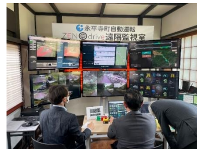
遠隔監視室の様子
