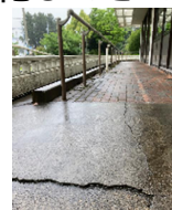
散歩コースの沈下
