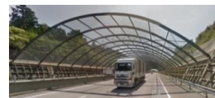
GPS精度低下区間の例（金属ネット）
