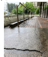
散歩コースの沈下
