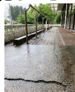
散歩コースの沈下
