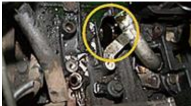
<エンジンの破損状況>
