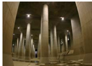
【首都圏外郭放水路の調圧水槽】
