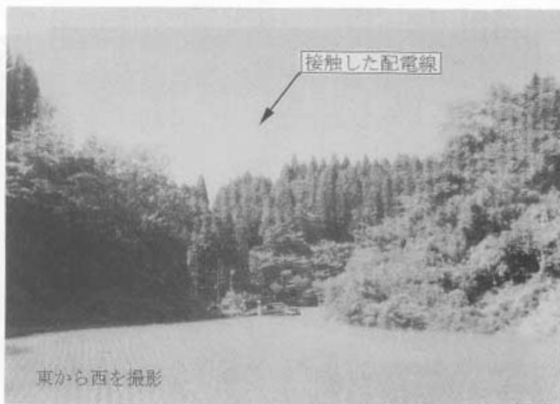
写真1 接触した配電線（復旧後）
