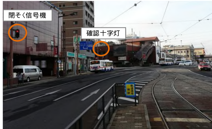
閉そく信号機の見通し状況
