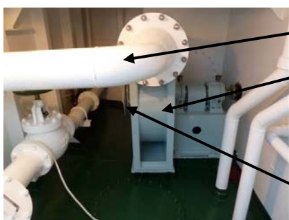
送風配管 送風ファン 排気ファン 送風ファンの吸入口
