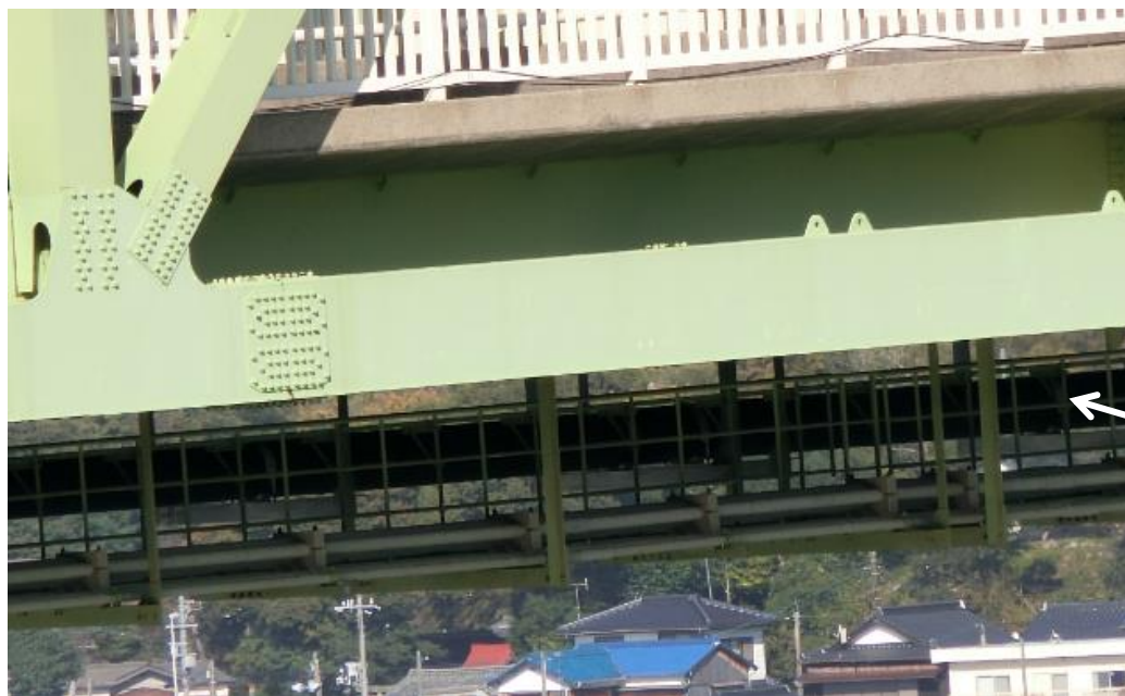
水道管等の設置状況（P4橋脚から周防大島町寄り）
