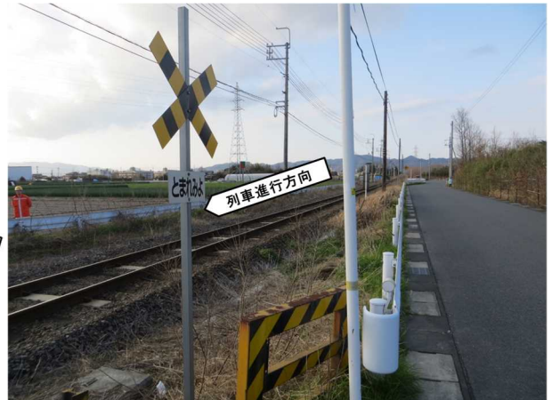
<原付進入側から見た列車見通し状況>
