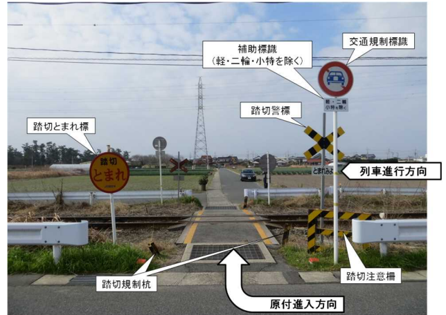
<原付進入側から見た新屋第3踏切の状況>
