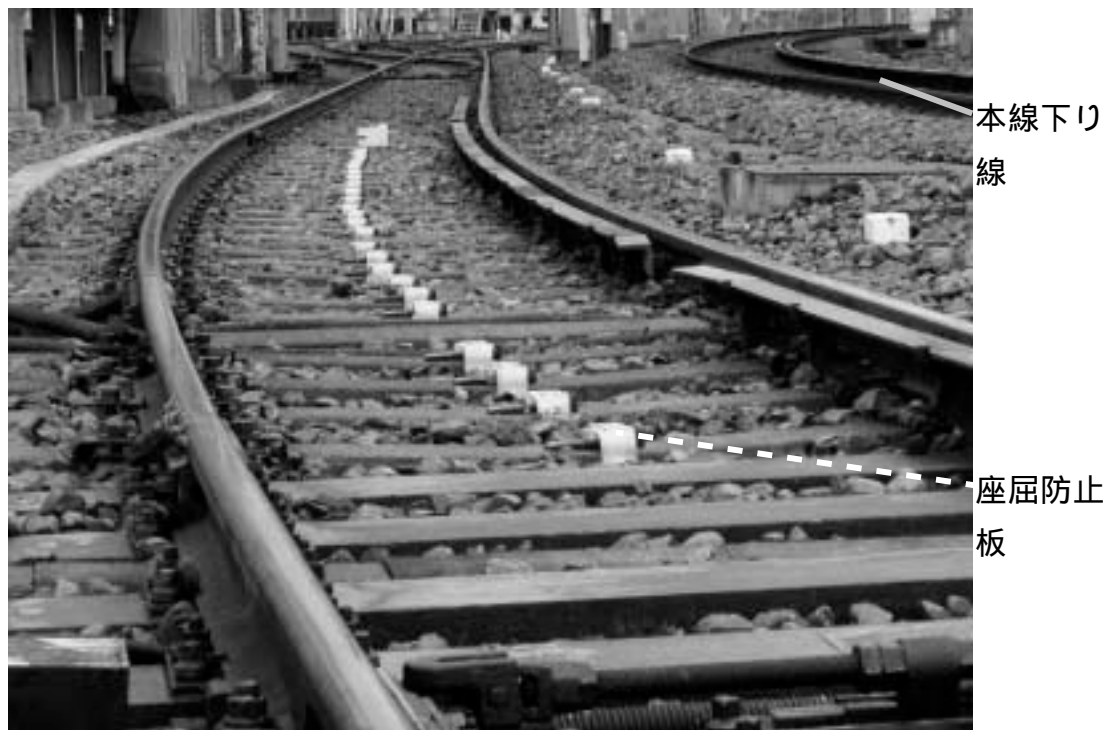
写真2 高砂車庫G線の曲線部
