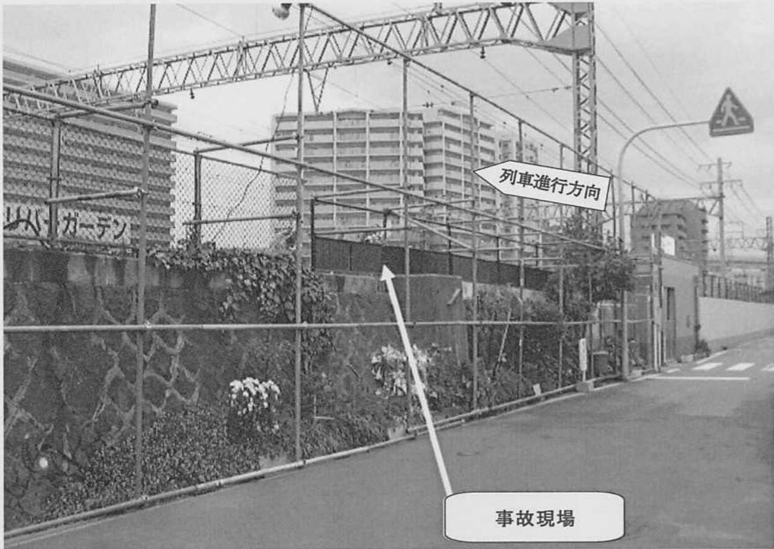
写真1 事故現場の状況（1）
