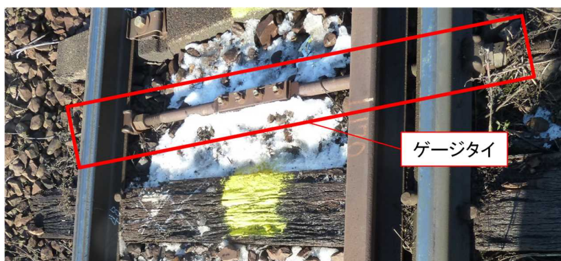
図10 ゲージタイの設置例
