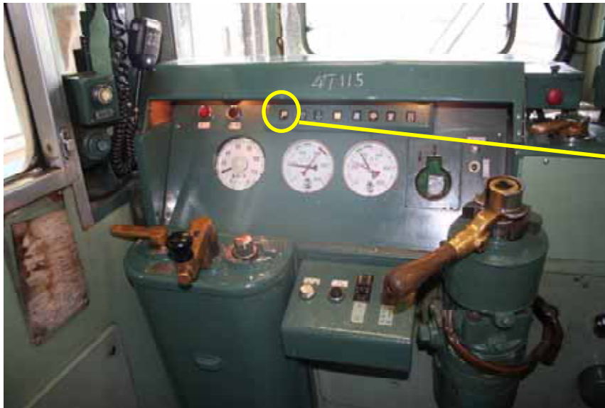
写真2 キハ47運転台の戸閉め表示灯
