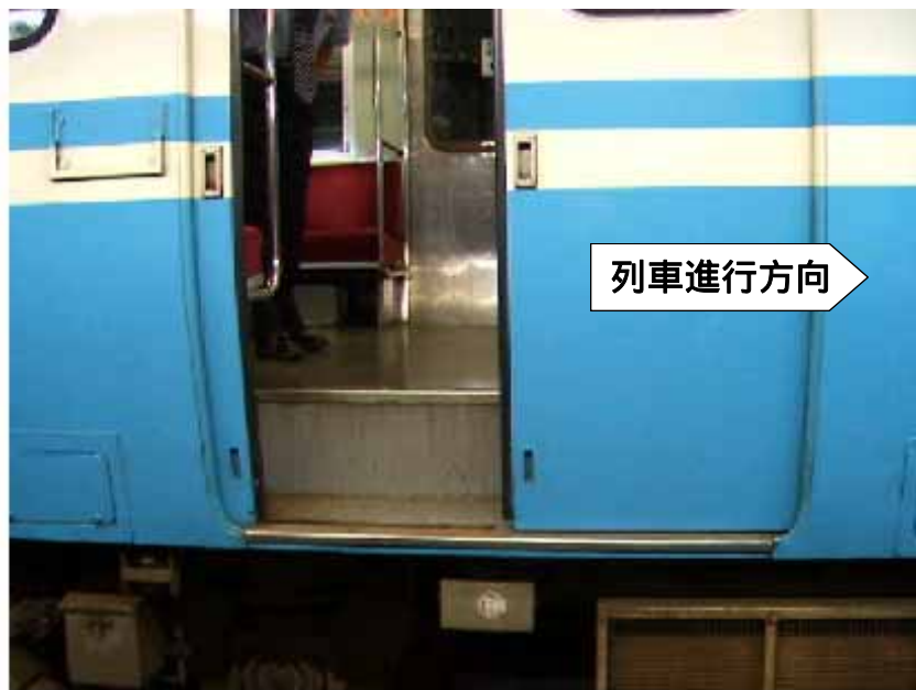
写真3 本件側引戸が引かなかった状況
