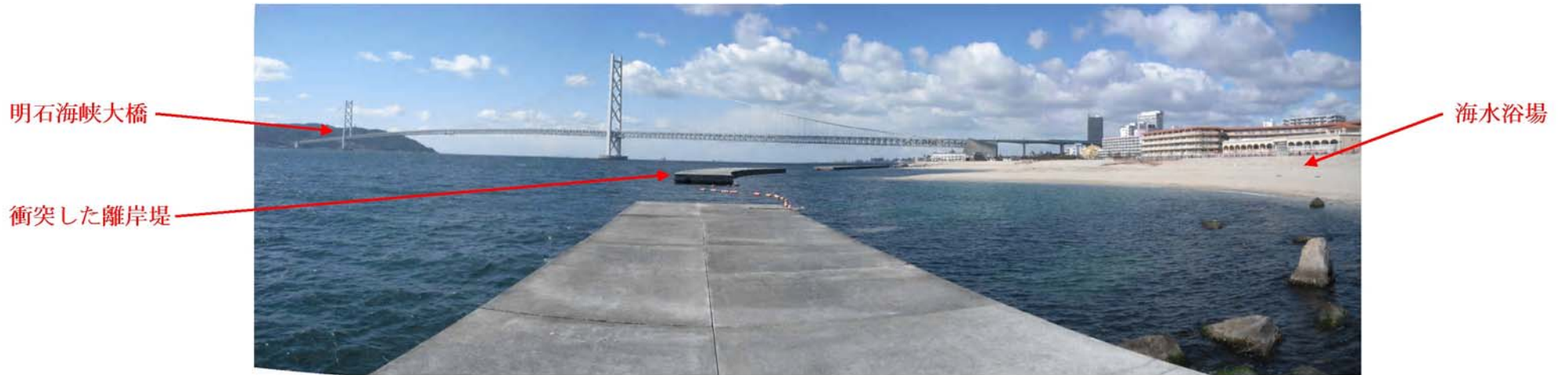
写真4 西側から見た離岸堤
