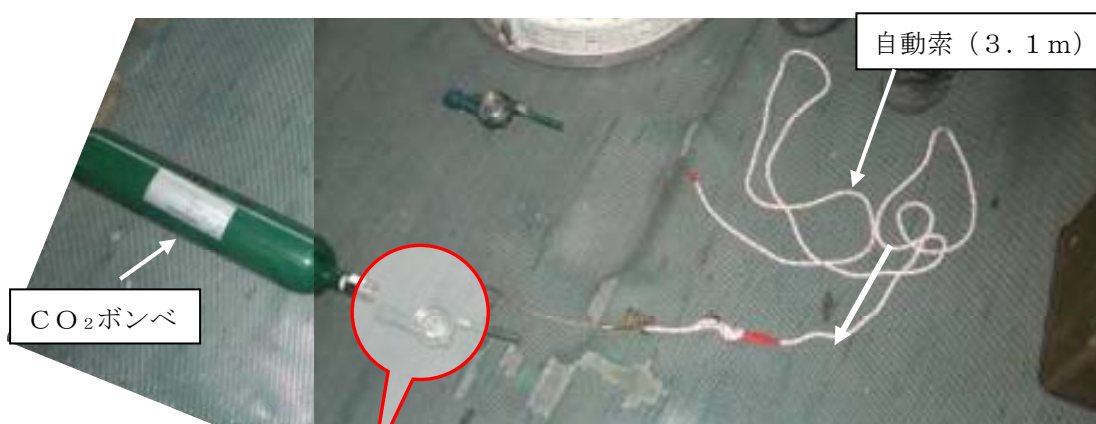
[自動索とCO 2 ポンベの接続状況]
