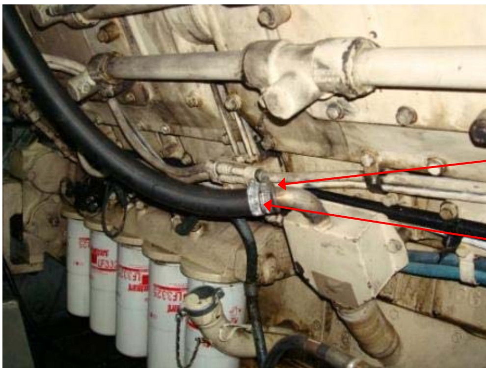
写真5 改良後のミスト管取付口
