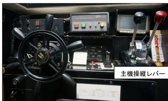
写真2 操船区画内の操縦装置
