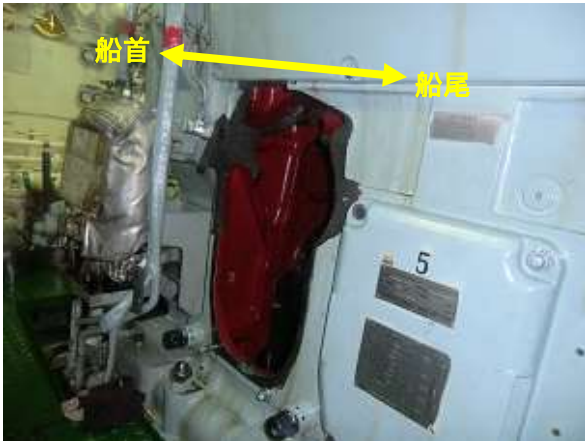
写真1 6番シリンダクランク室の 損傷状況
