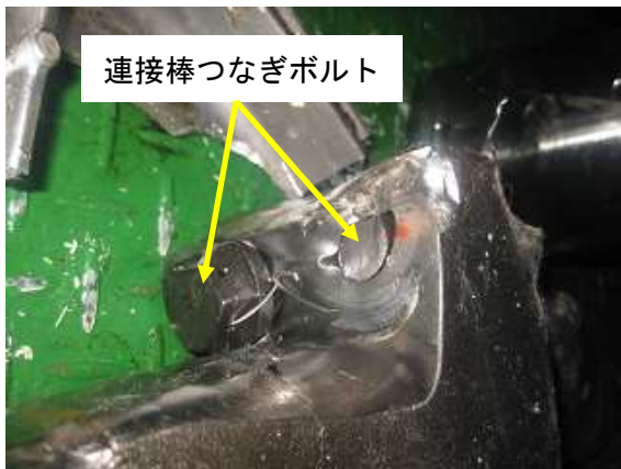
写真7 6番シリンダ接続棒つなぎボルトの折損状況1
