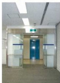
A 入口の自動ドア化 ドア有効幅員の拡張も含めた自動ドア化を実施している。
