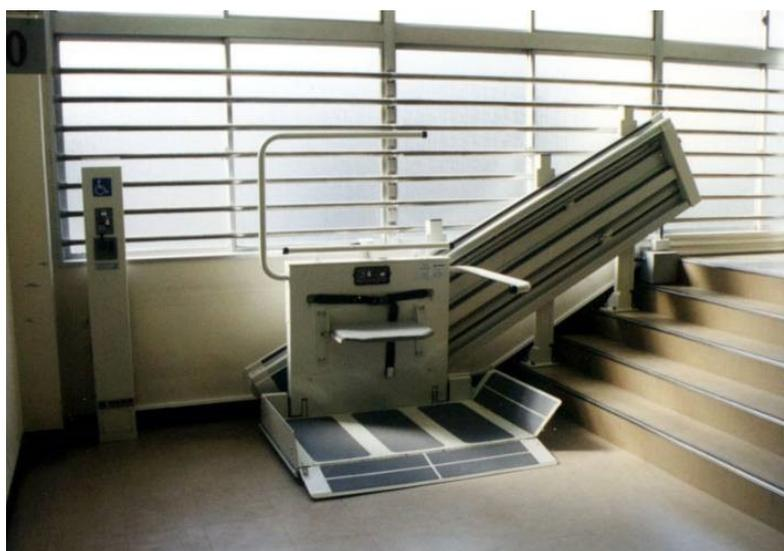
・既存施設の階段に設置した斜行型段差解消機
