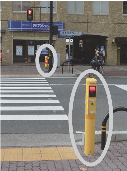
低い位置に設置された補助信号機（目を近づけて見ることができる）
