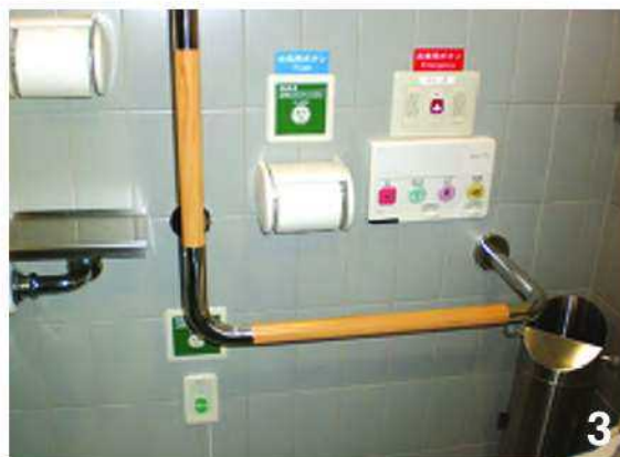
JIS規格に沿った配置をしているトイレ操作盤
